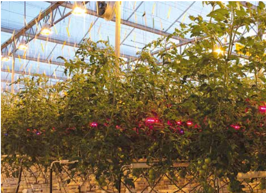
Het gebruik van bijkomende ledbelichting heeft efficiëntie-voordelen in vergelijking met alleen de klassieke belichting met hogedruknatriumlampen.
